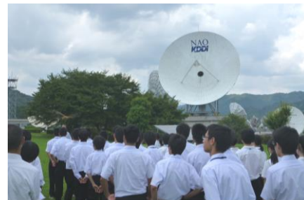
KDDI 山口衛星通信センター
